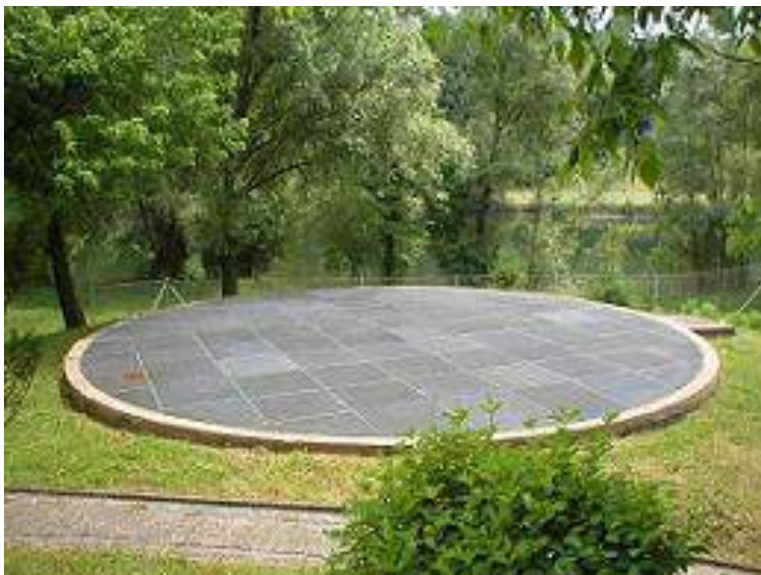
Slika 2.2.-4. Bioaeracijski bazen BIOTIP 1500 ES.
